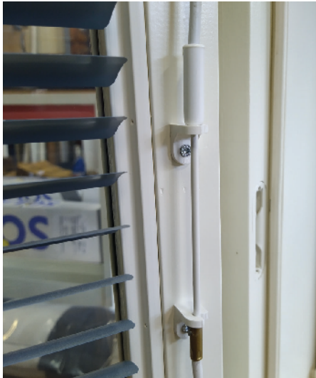
17. Pujota naru narunupin läpi. Kaihtimen ollessa laskettuna, tee kynällä pieni merkki naruun säätimen ulostuloaukon kohdalle. Vedä sitten naru hieman ulospäin ja tee solmu merkaamaasi kohtaan. Leikkaa naru poikki solmun läheltä.
