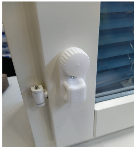
19. Laita narunuppi kiinni Sun-säätimeen. VALMISTA TULI!
